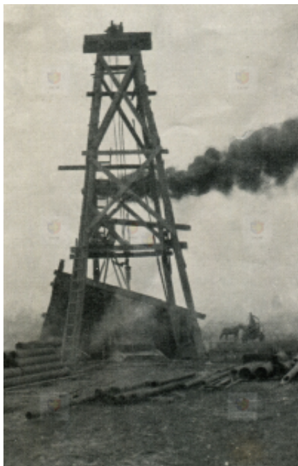
Fotografia przedstawiająca pierwszą wieżę szybową w Jedłowniku. Drewniany szyb który powstał przed wojną, następnie został zastąpiony przez nowsze konstrukcje. Pierwotnie kompleks na Jedłowniku miał być osobną kopalnią węgla kamiennego z wybudowaną obok koksownią.
