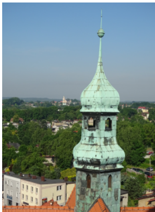
Wieże kościelne kryją swoje tajemnice. Mała wieża, oryginalna z czasów budowy świątyni, nosi liczne ślady po kulach pocisków, uderzających w nią 25 i 26 marca 1945 r.
