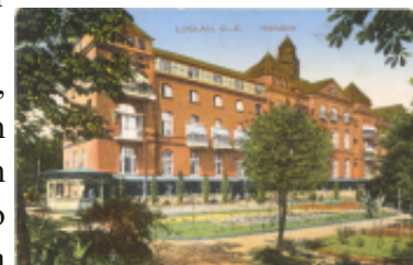
Zabytkowy budynek dawnego Sanatorium, dziś Wojewódzki Szpital Chorób Płuc
