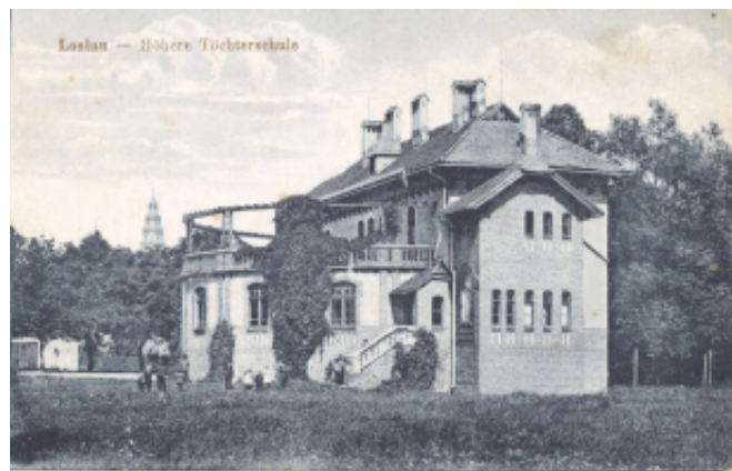
Budynek kolejno szkoły, ośrodka zdrowia i Sanepidu
