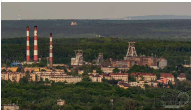
KWK Chwałowice, dalej widoczny komin Elektrowni Jaworzno a w tle zarys Jury Krakowsko-Częstochowskiej
