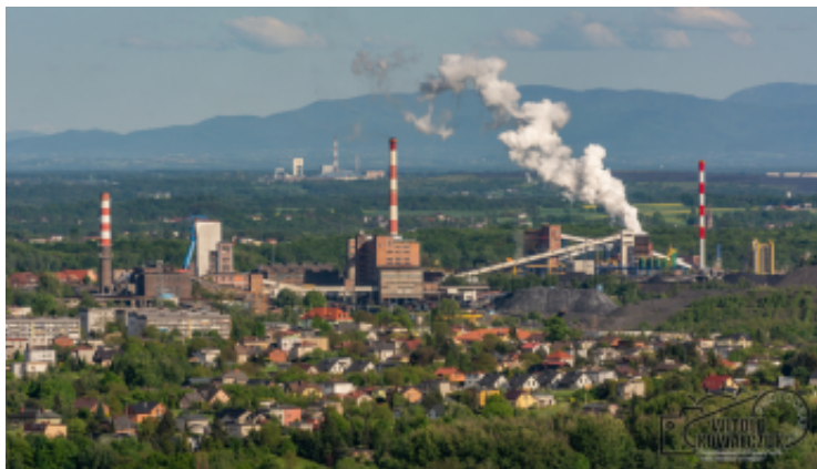
Widok na KWK Marcel i Koksownię Radlin. W tle z prawej strony Skrzyczne
